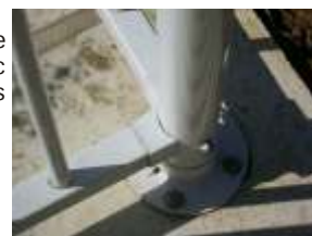
Vue supérieure d'un poteau d'angle sans cache de jonction.
